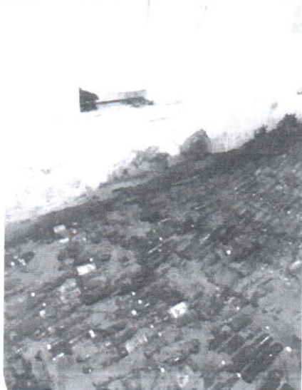
Рис 2. Пляшки повинні бути закупорені та укладені так, щоб між ними було як можна менше вільного простору
