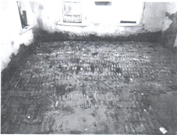
Рис 3. Піщаний шар поверх шару пляшок, змитий водою
