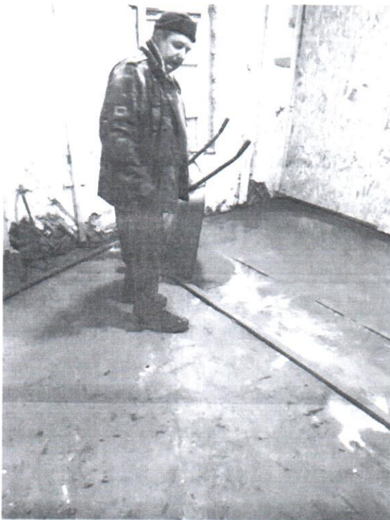
Рис 4. Залиття пляшкового шару розчином цементно-піщаної суміші
