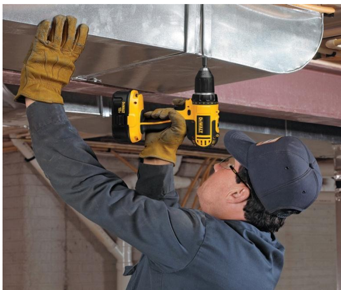
Мал. 2.35 Виконання роботи електрошурупвертом
