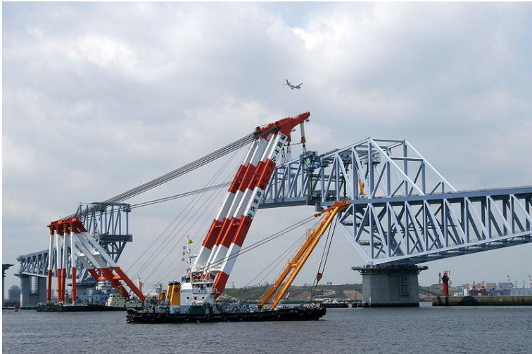
Мал.1.59. Плавучий кран при будівництві мосту у Токіо, 2010 року
