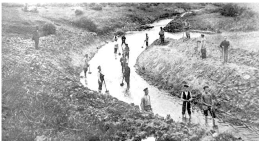
Гідромеліоративні роботи по осушенню боліт. Початок ХХ ст. Фото із сайту: www.tversu.ru .
