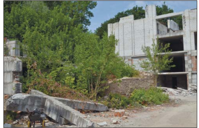
Іл. 5. Рештки кам'яниці магістрату в зоні недобудови готельно-туристичного комплексу. Світлина перед розчисткою 2020 р.
