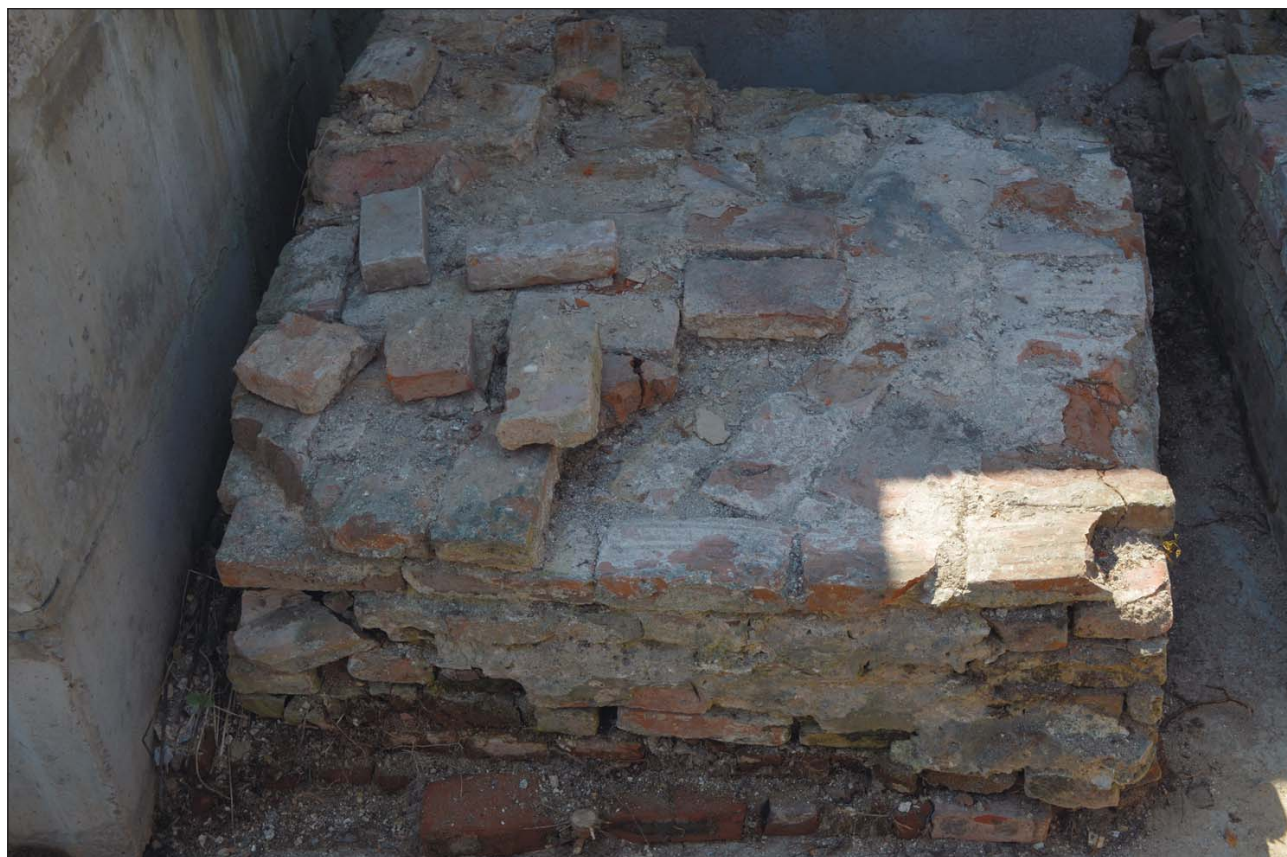
Іл. 12. Мурування опорного стовпа. Світлина 2020 р.
