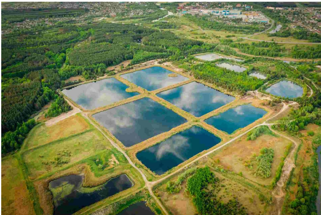
Рисунок 1.1 – Приклад очисної споруди типу «біоплато».
